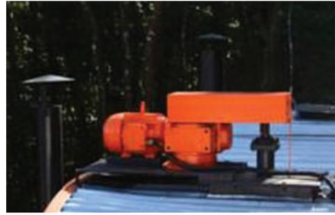
Detalhe de agitadores nos tanques de estocagem
