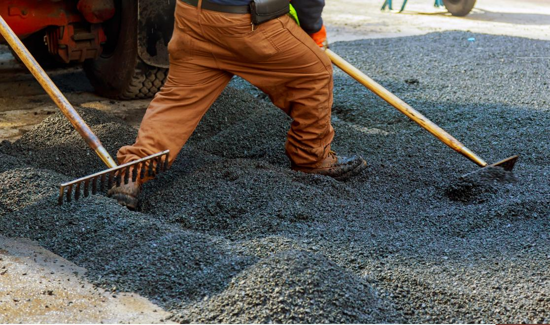
O **primeiro passo** é o projeto da mistura asfáltica, que pode ser comparado a uma receita de bolo. Nessa receita, os ingredientes principais são: o ligante asfáltico (como o CAP ou um ligante modificado) e os agregados (brita, pó de pedra, areia). **Cada “ingrediente” precisa estar na proporção correta** para que a mistura atinja os níveis desejados de resistência, flexibilidade e durabilidade.
